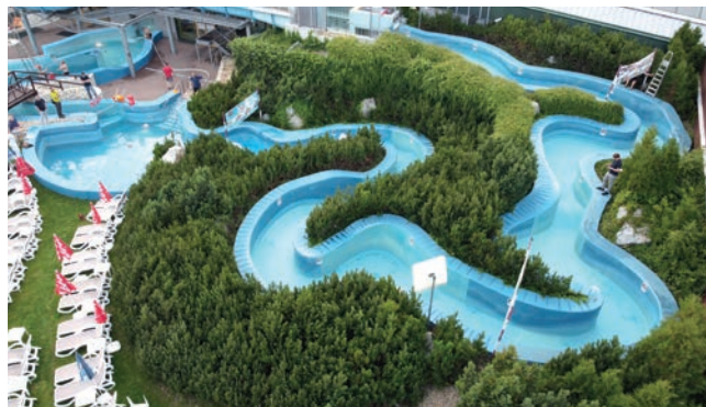
Pasportizace stávajících atypických prvků bude využívána pro technickou správu nemovitostí a návrh dalších stavebních úprav v areálu
